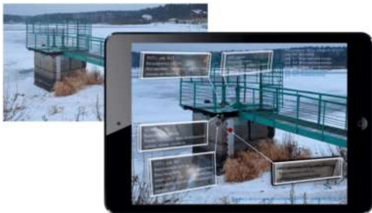
Рис. 1. Пример возможного использования результатов цифрового проектирования и технологии дополненной реальности при приемке ремонтных работ гидроузла
